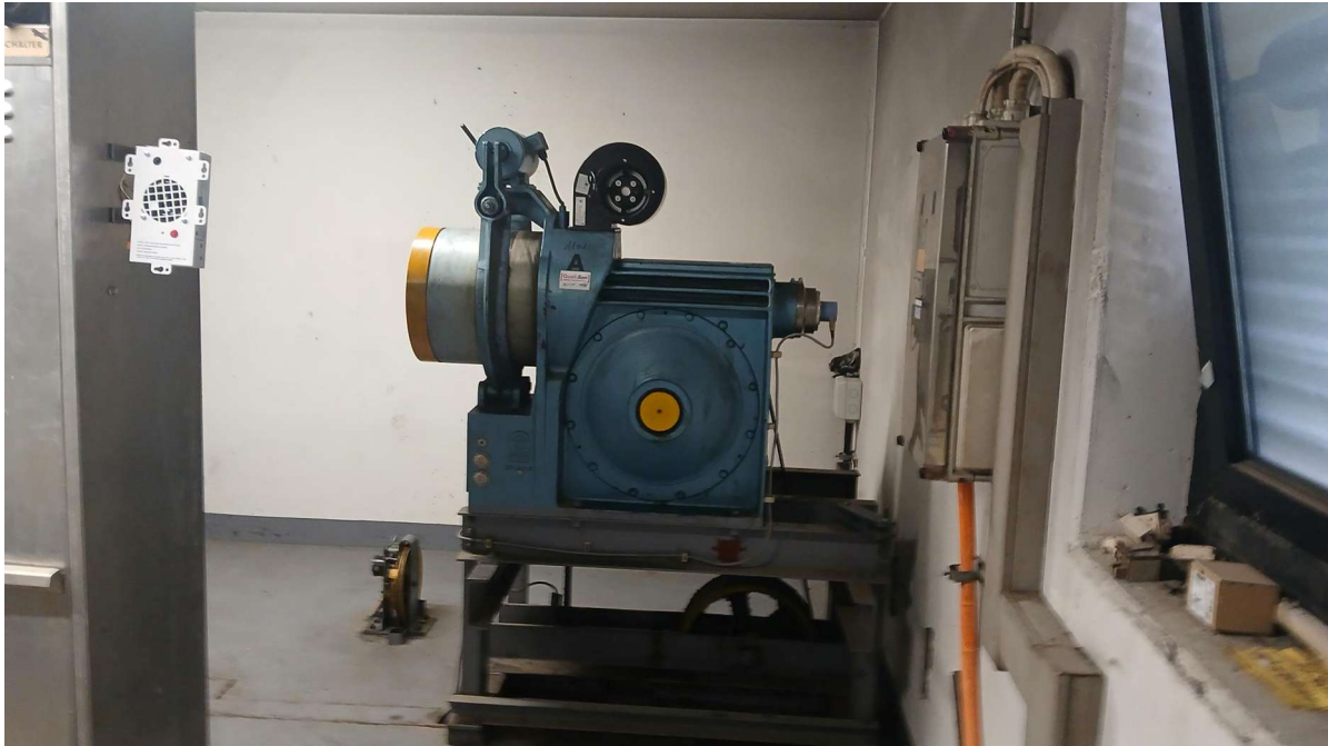
Bild 2) Aufzugstriebwerk
