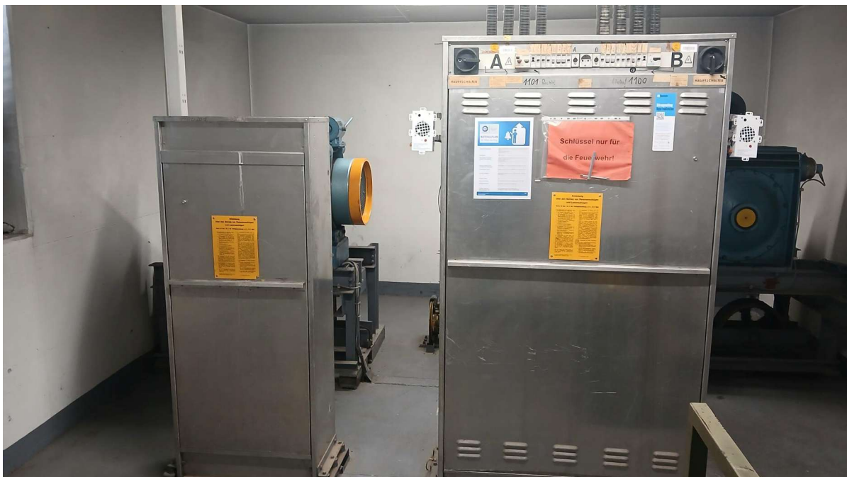
Bild 3) Aufzugssteuerung Vorderseite
